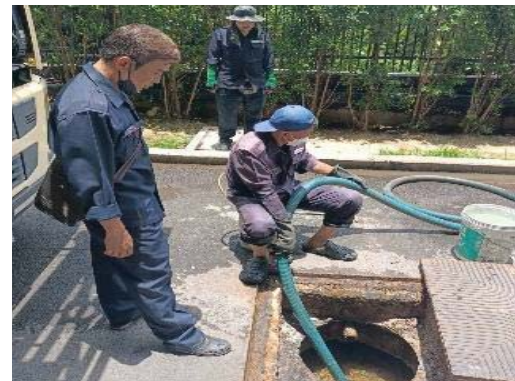
สูบตะกอน และไขมันจากระบบบำบัดน้ำเสีย
