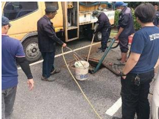
สูบตะกอน และไขมันจากระบบบำบัดน้ำเสีย
